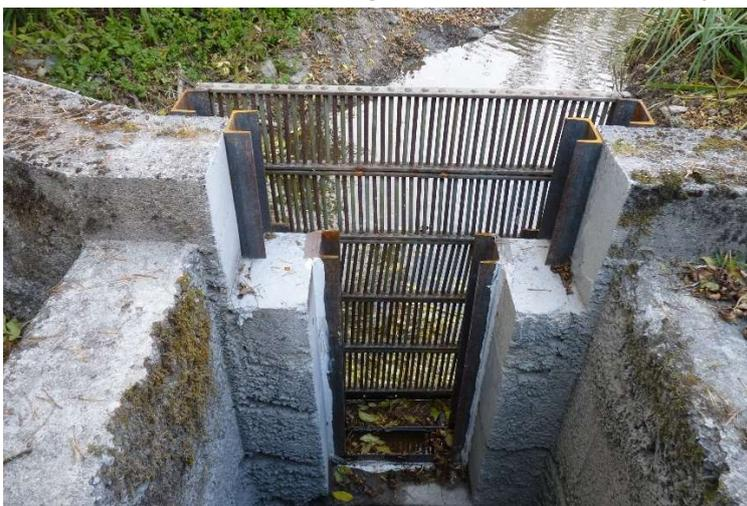
Figure 9 – Déversoir de la digue de Malaguet (source PNRLF)
